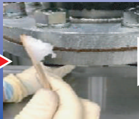
② 漏油箇所に塗布
