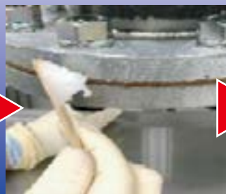
② 漏油箇所に塗布
