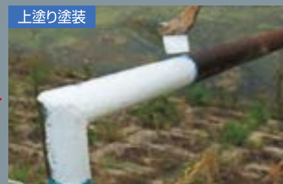
乾燥後、一般塗料で上塗り塗装。
