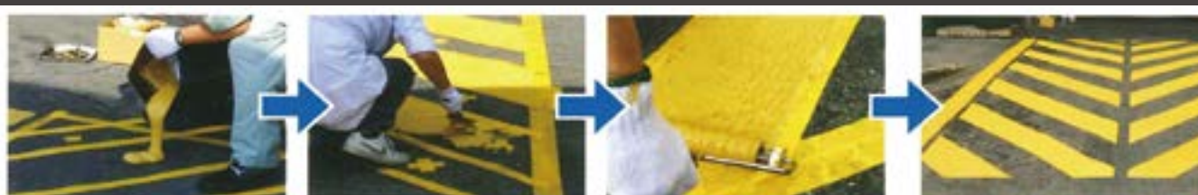
混合したすべり止めコートを塗布面に直接垂らします。
